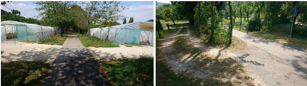
Abbildung 38: Kreuzung der Trasse mit der Zufahrt zu den Gewächshäusern, Blickrichtung Pfullingen: Kreuzung der Trasse mit der Grundstückszufahrt, der Durchlass ist am Geländer zu erkennen.
