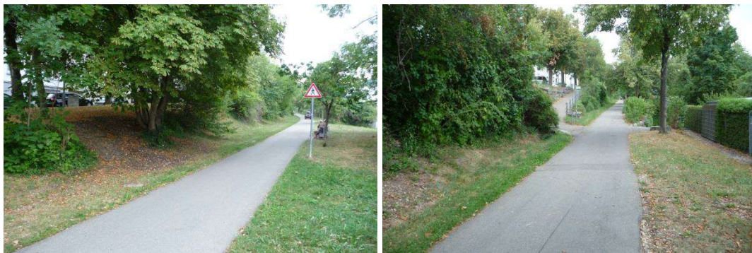
Abbildung 14: Trassenverlauf der Regional-Stadtbahn auf alter Trasse und Bereich des Haltepunkts Schulstraße, Blickrichtung Lichtenstein Standpunkt an der Schulstraße, (links), Standpunkt kurz vor dem Verbindungsweg Bad- und Gartenstraße (rechts).
