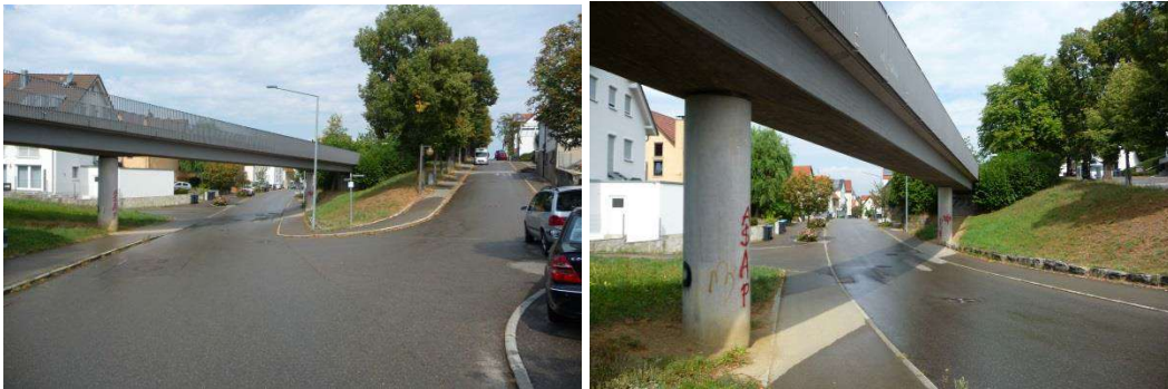
Abbildung 16: Bestandsbrücke über die Große Heerstraße. Blickrichtung Pfullingen Innenstadt. Übersicht über die Brücke (links) und Ansicht der Pfeiler (rechts).
