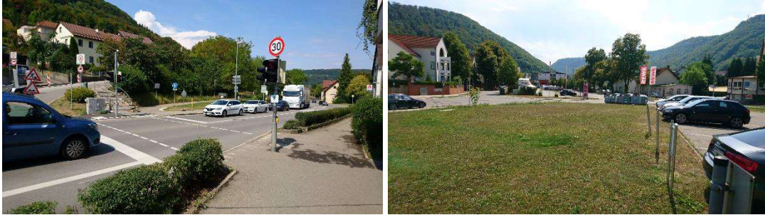
Abbildung 45: Übergang über die heutige B 313 in Unterhausen Bahnhofstraße, Grün- und Parkplatzfläche vor dem Supermarkt in Blickrichtung Honau.
