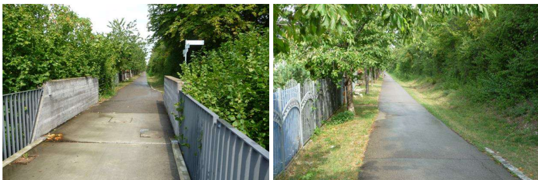
Abbildung 15: Trassenverlauf der Regional-Stadtbahn auf alter Trasse, Blick von der Brücke über die Große Heerstraße in Richtung Pfullingen Bahnhof mit dem nördlichen Widerlager (links) und Detailaufnahme des Bereichs der neuen Haltestelle (rechts).
