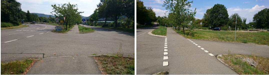
Abbildung 37: Kreuzung der Trasse mit der Roßwagstraße, Überweg Feldweg im Hintergrund. Kreuzung der Trasse mit dem Feldweg, Überweg Roßwagstraße im Hintergrund.
