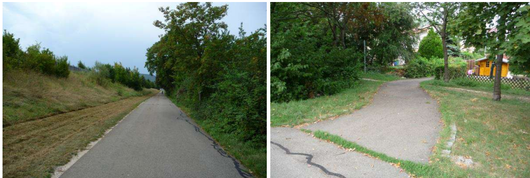
Abbildung 9: Neuer Trassenverlauf auf dem Rad- und Fußweg, mit Lärmschutzwand der B 313 links, Blickrichtung Pfullingen Bahnhof (links), Zugang zum Rad- und Fußweg von der Hauffstraße kommen, mit dazwischen liegender alter Bahntrasse (rechts).
