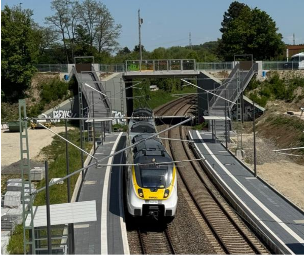
Abbildung 3: Bauzustand Haltepunkt RTunlimited im Sommer 2025
