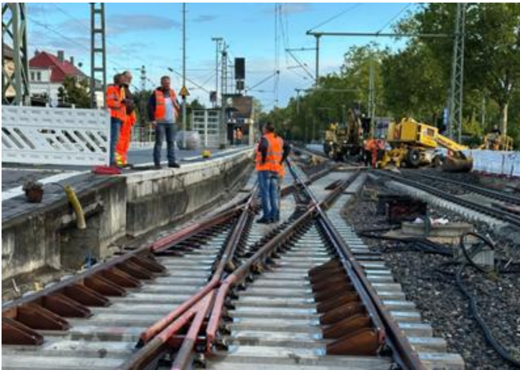
Abbildung 2: Gleisbau- und Oberleitungsarbeiten im Bahnhof Metzingen im August 2025
